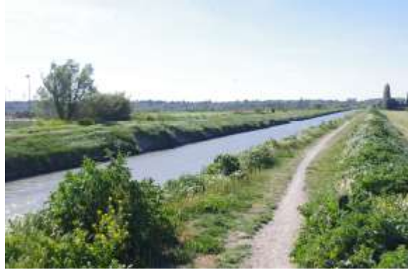
Figure 7 – Canal du Vigueirat
